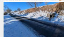
Štola za silnicí EXIF: 19.2.2025 11:43:03 19.02.2025
